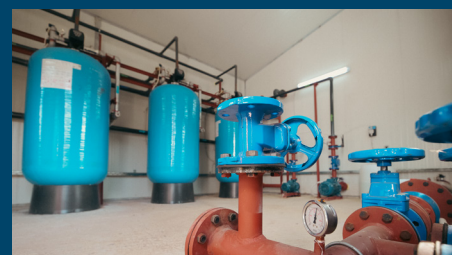
Εγκατάσταση μονάδων αποσιδήρωσης πόσιμου νερού στην τοπική κοινότητα Βραστών και στον οικισμό Πλανών δήμου Πολυγύρου
