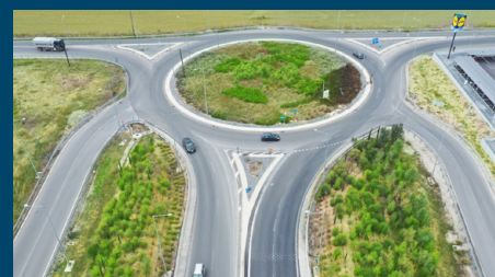
Κατασκευή οδικού τμήματος Ποτίδαια – Κασσανδρεία στη Χαλκιδική
