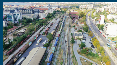
Αναβάθμιση σιδηροδρομικής γραμμής Θεσσαλονίκης - Ειδομένης και σύνδεση με το λιμάνι Θεσσαλονίκης
