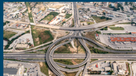
Κατασκευή ανισόπεδου κόμβου Κ16 στη συμβολή ΠΑΘΕ και εσωτερικής περιφερειακής οδού Θεσσαλονίκης
